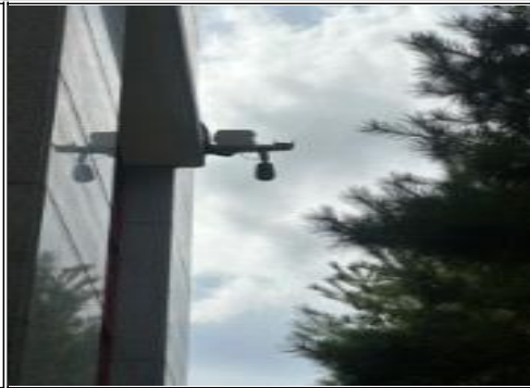
개선 후: 행정실 요청을 통한 설치
